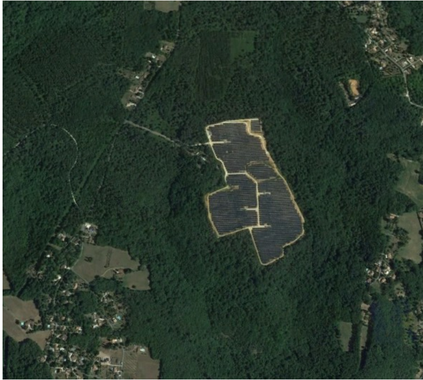
- Centrale Urbasolar à La Chapelle Gonaguet -
