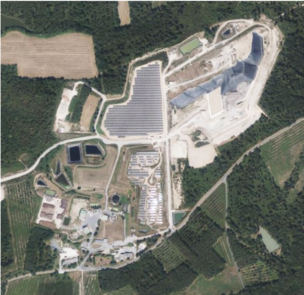
- Centrale sur site SMD3 à Saint-Laurent des Hommes -
